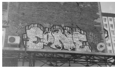
Рис. 4. «EONE» вблизи здания администрации г. Иваново
